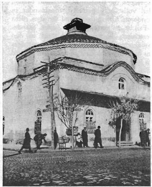
Öffentliches Bad in Plovdiv (Philippopol), Bulgarien. Der Eingang mit dem dahinter liegenden Auskleide- und Ruberraum, dessen Größerverhältnisse schon äußerlich zu erkennen sind. Aufnahme von Prof. Wateff in Sofia.
