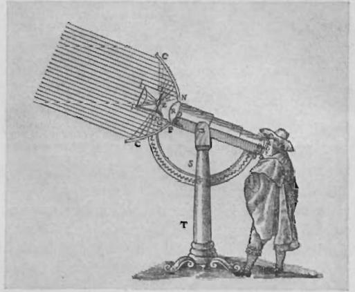
Darstellung eines sog. Megaloskopes, einer Art von Mikroskop, dessen Konstruktion von René Descartes (1596 bis 1650) vorgeschlagen worden ist. Aus «Specimina philosophiae, ... Dioptrice, et Meteoræ». Amsterdam 1664.
